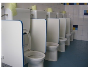
MŠ - chybějící WC poklopy, které představují významnou bariéru proti šíření původců zejména virových nákaz při splachování
