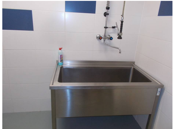
Prostor mytí termosů s instalovaným dřezem
