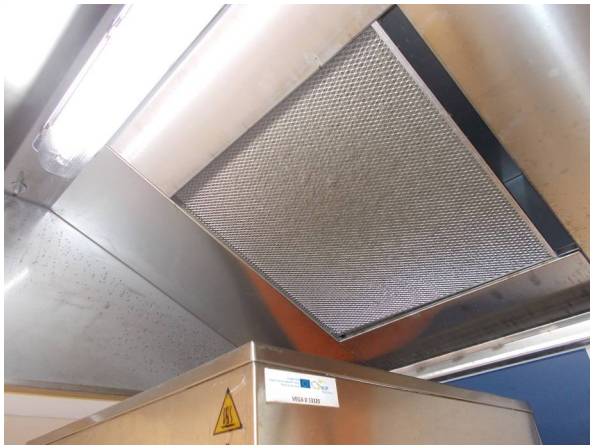
Znečištěná digestoř
