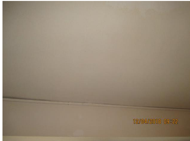
Stav stěn a stropu při opakované kontrole:
